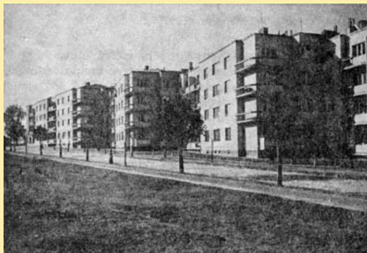
Ul. Gdańska 2 – budynek Spółdzielni widziany od ul. Potockiej – 1938 r.
